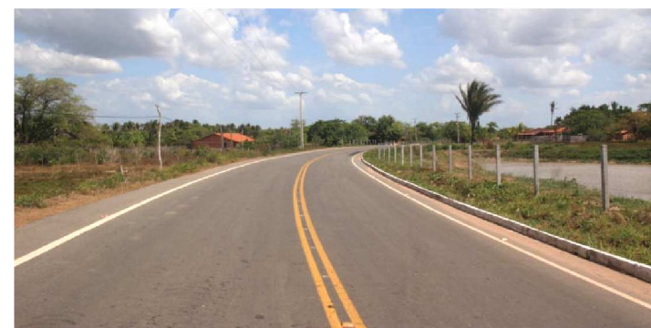
NA MA-110 FORAM FEITOS SERVIÇOS DE SINALIZAÇÃO
