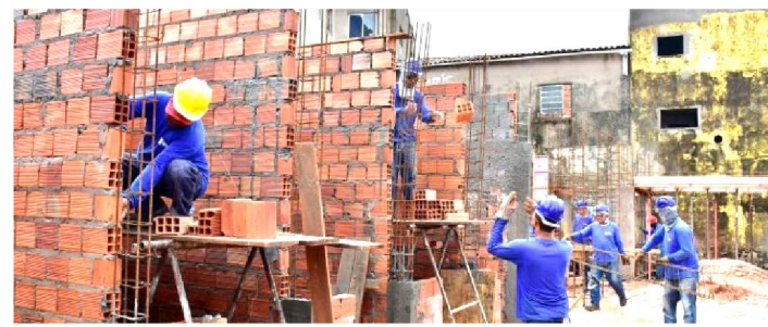
OBRAS FORAM VISTORIADAS PELO PREFEITO EDIVALDO
