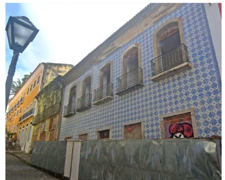
GESTÃO EDIVALDO AVANÇA COM OBRAS E REFORMA DO PRÉDIO
