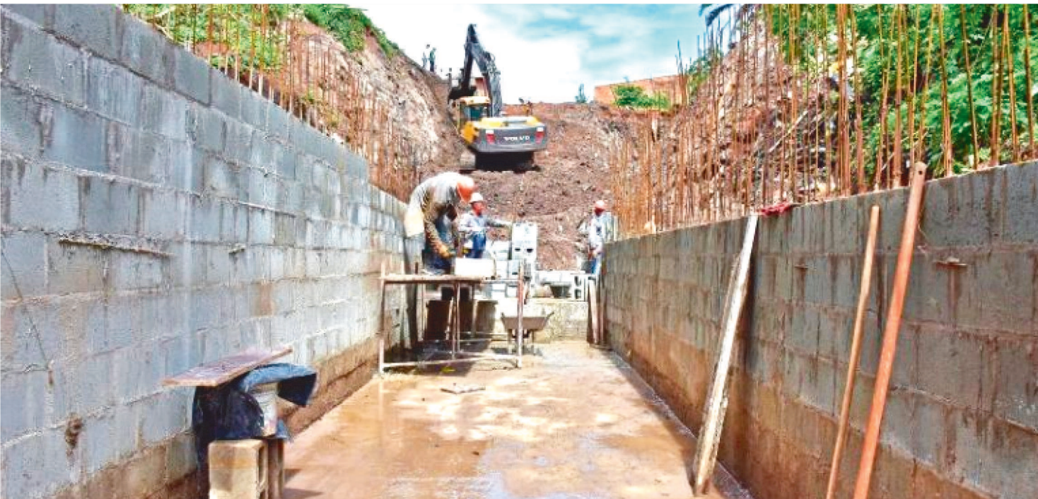
JÁ SÃO MAIS DE 40 KM DE REDE CONSTRUÍDOS NOS ÚLTIMOS ANOS COM A CONSTRUÇÃO DE CANAIS E GALERIA
