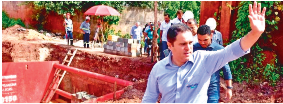
PREFEITO EDIVALDO ACOMPANHA DE PERTO AVANÇOS DAS OBRAS DE DRENAGEM
