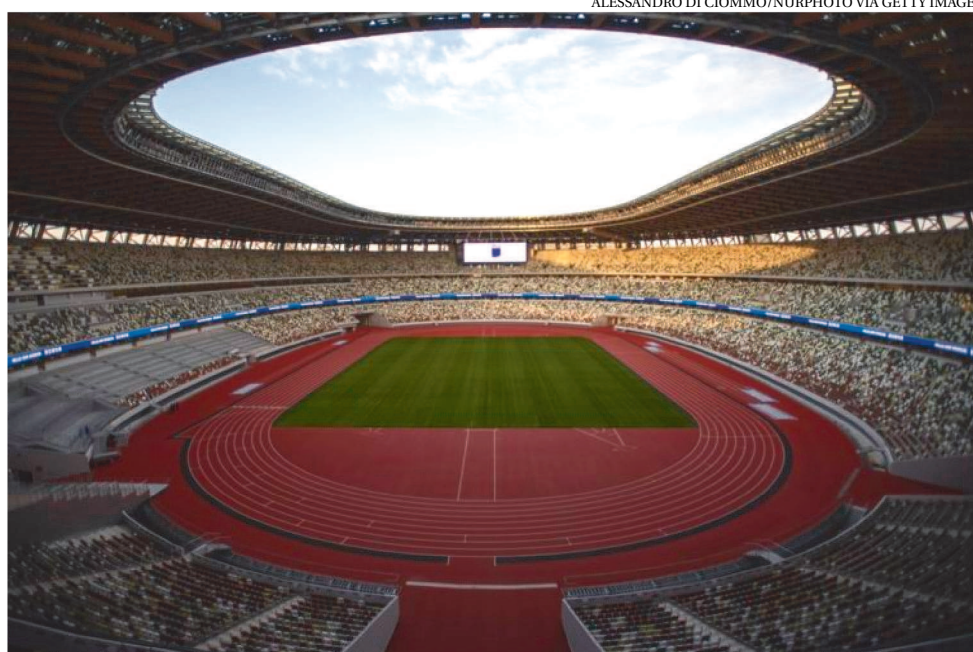
ESTÁDIO NACIONAL DE TÓQUIO FINALIZADO PARA A OLIMPIADA DE 2020
