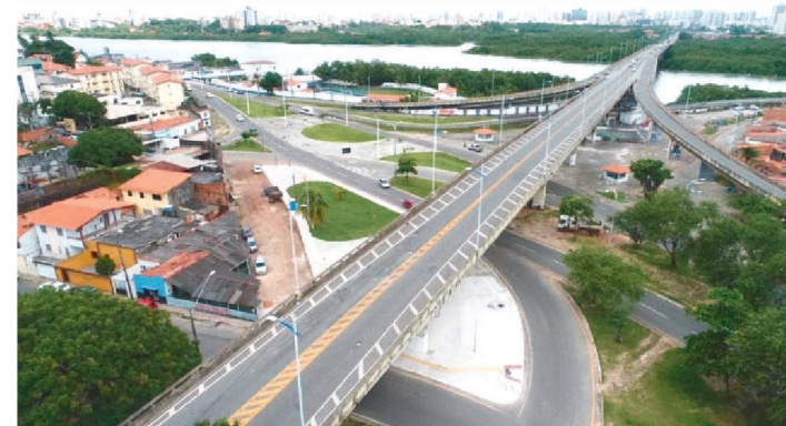
OBRA POSSUI ÁREA TOTAL DE 1.887 M² NA ÁREA DA CAMBOA
