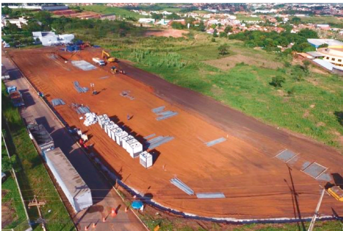
CONSTRUÇÃO DO HOSPITAL DE CAMPANHA EM AÇAILÂNDIA
