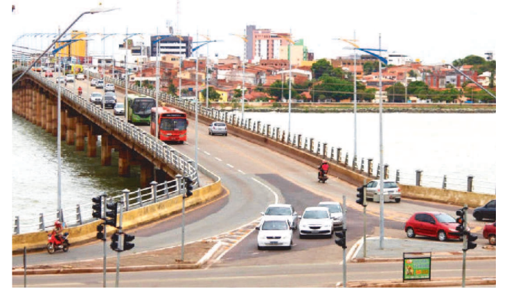
PONTE DO SÃO FRANCISCO É UM DOS LOCAIS DE FISCALIZAÇÃO
