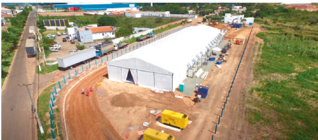
A ESTRUTURA CONTARÁ COM 200 LEITOS, SENDO 186 LEITOS CLÍNICOS E MAIS 14 DE UTI
