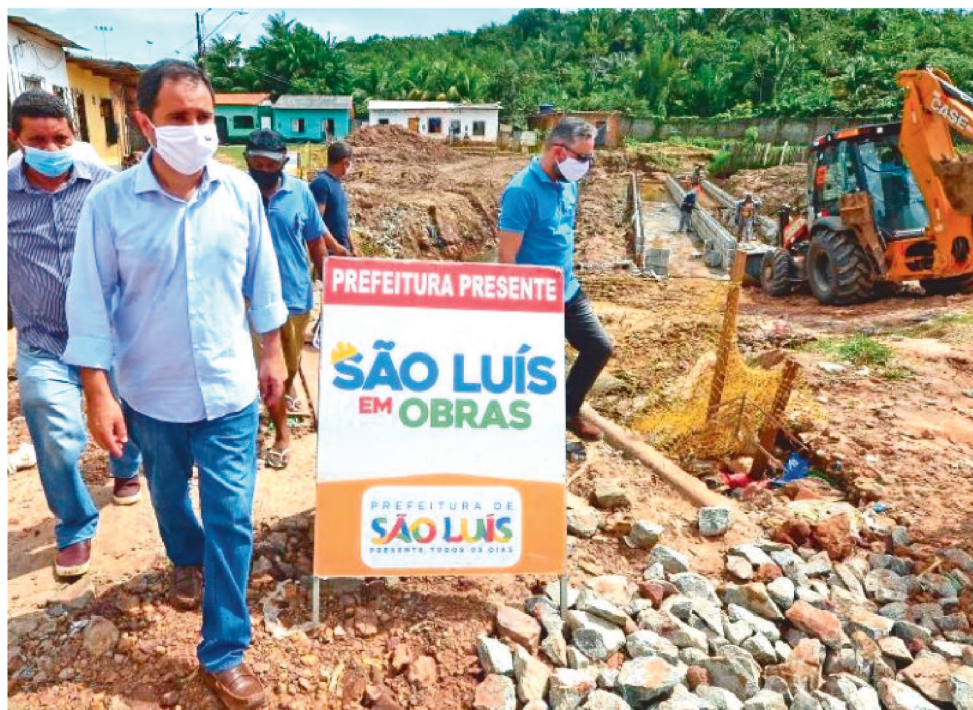
PREFEITO EDIVALDO ESTENDE INFRAESTRUTURA NO FUMACÊ, NO ANJO DA GUARDA
