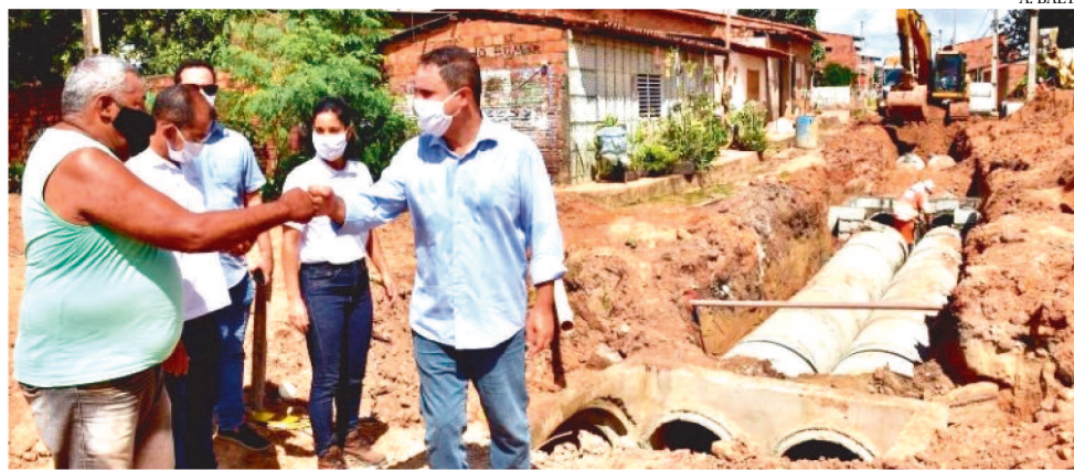
PREFEITO EDIVALDO ACOMPANHOU AVANÇO DAS OBRAS NO BAIRRO DA CAPITAL
