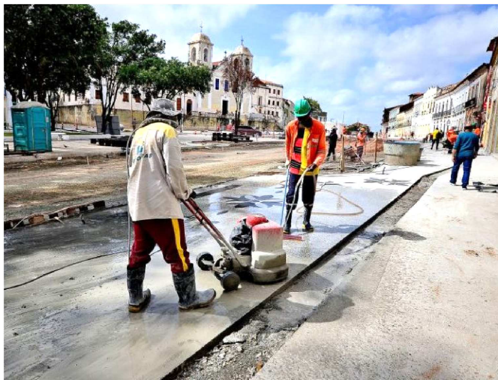
ESTÁ SENDO CONCLUÍDO O TRABALHO NO PISO, TOTALMENTE REFORMADO
