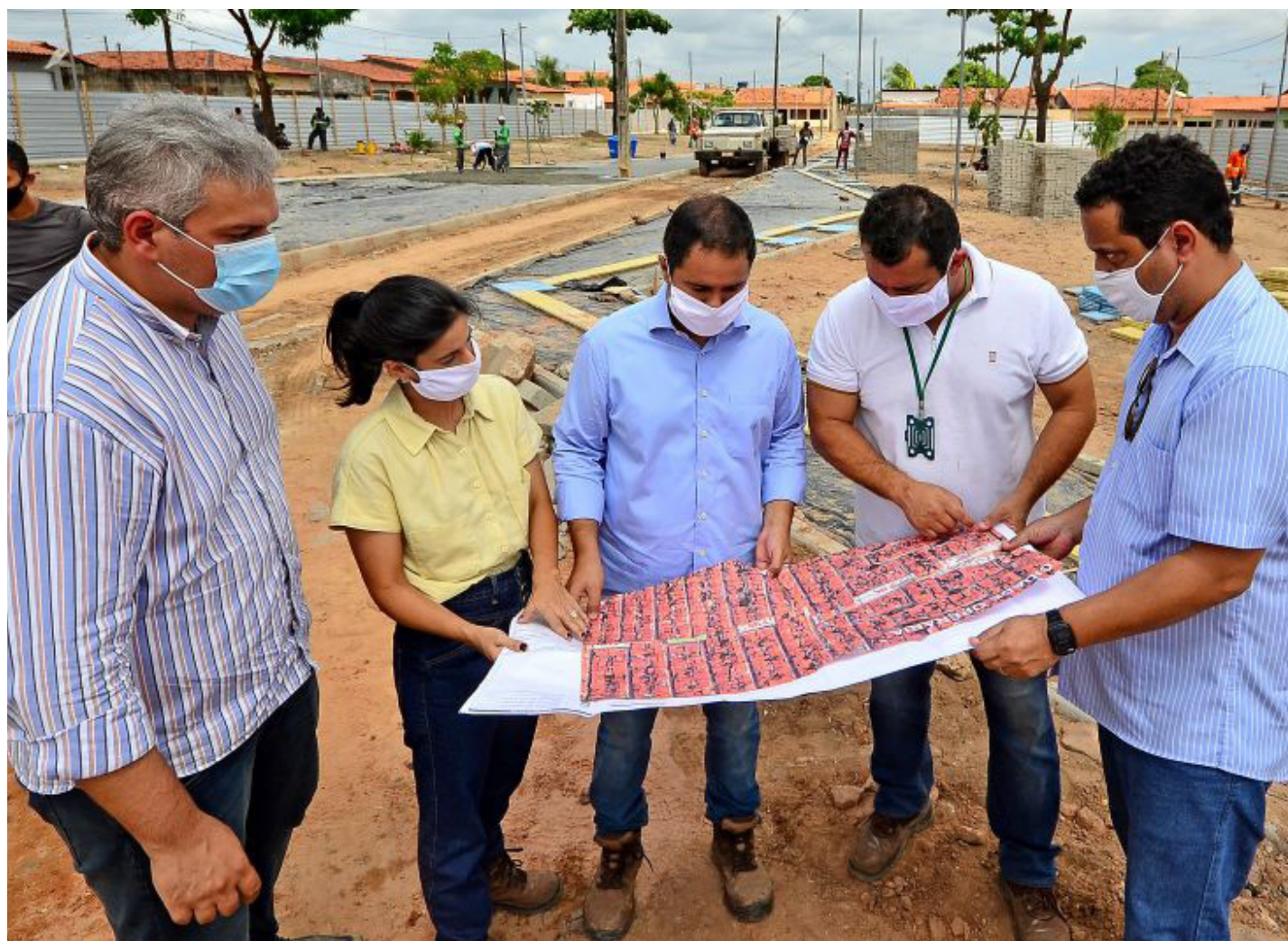
Prefeito Edivaldo vistoria construção de ciclovia e conjunto de praças na Cidade Operária
