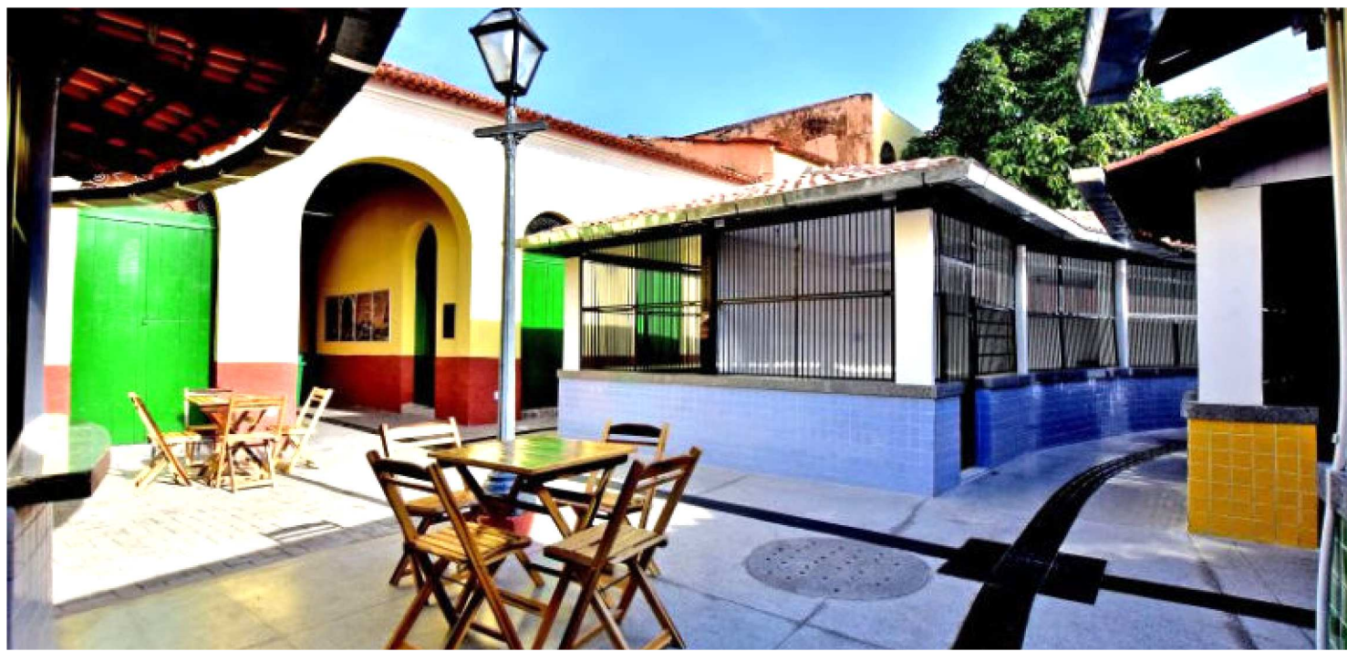
OS BOXES FORAM REFORMADOS E PADRONIZADOS COM PISO NOVO, PAREDES REVESTIDAS DE CERÂMICA
