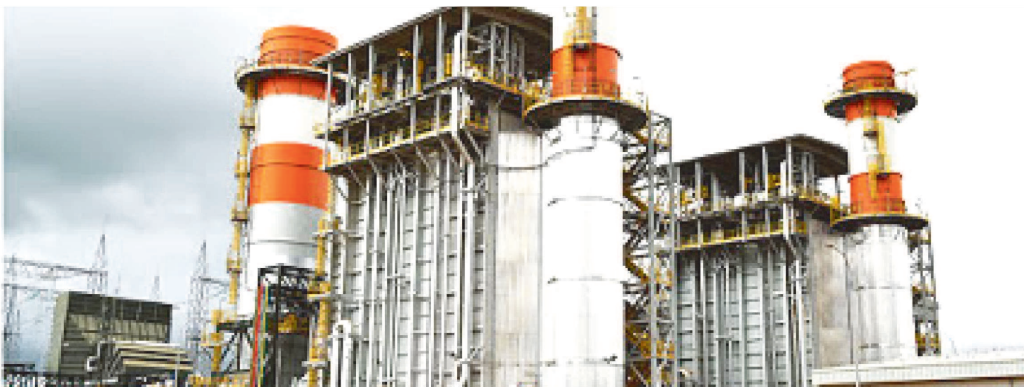
TURBO GERADOR TEM 106 METROS E VAI SAIR DO PORTO DO ITAQUI PARA A USINA TERMOELÉTRICA EM SANTO ANTÔNIO DOS LOPES
