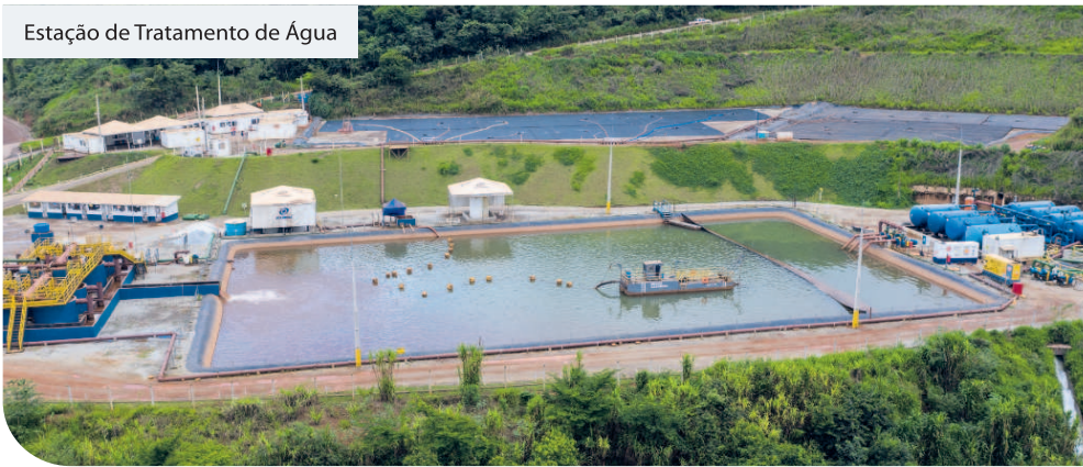
Estação de Tratamento de Água
