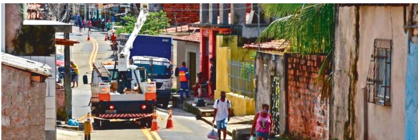
A SINALIZAÇÃO DA SMTT CONSISTIU EM PINTURA DE FAIXA DE PEDESTRES, FAIXA CONTÍNUA, SETA DE INDICAÇÃO DE SENTIDO DE VIA
