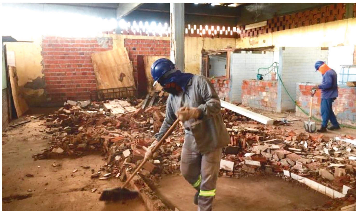
EQUIPES AVANÇAM NA EXECUÇÃO DOS SERVIÇOS DE DEMOLIÇÃO DAS ESTRUTURAS ANTIGAS QUE ESTAVAM DETERIORADAS
