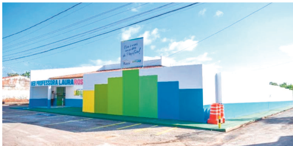
AS OBRAS INCLUÍRAM ADEQUAÇÃO DA ESTRUTURA NOS NOVOS PADRÕES SANITÁRIOS
