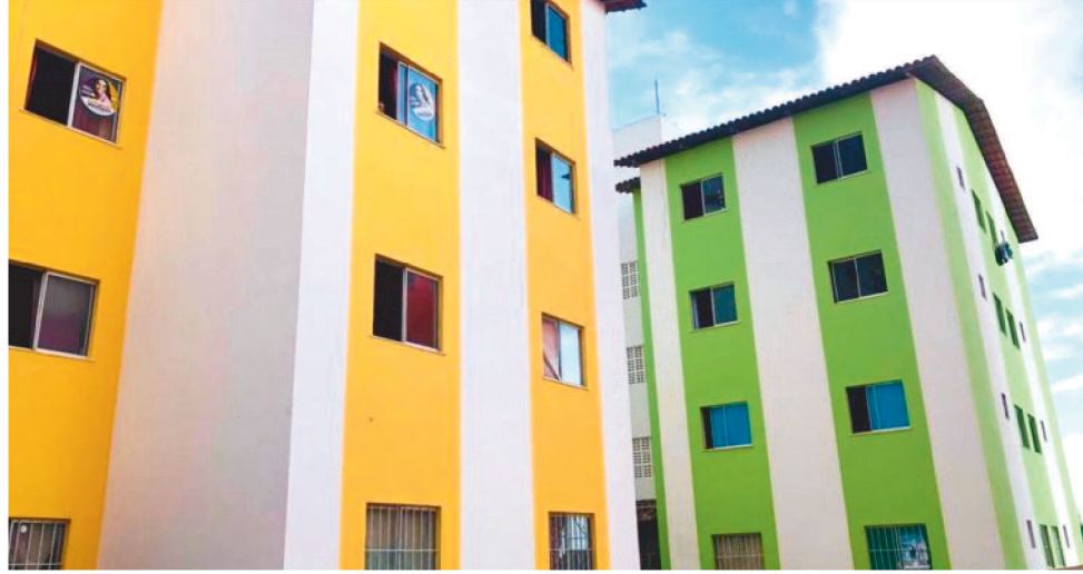
O RESIDENCIAL MONTE CASTELO POSSUI 14 BLOCOS COM 16 APARTAMENTOS CADA.
