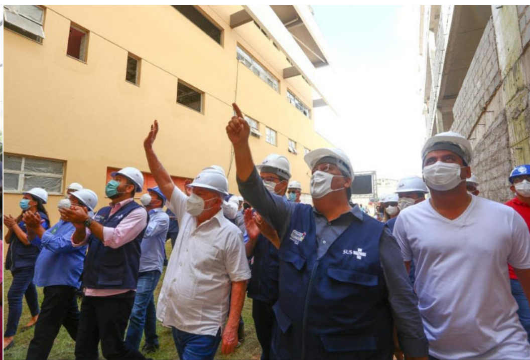
O HOSPITAL DA ILHA SERÁ UM DOS MAIORES HOSPITAIS DE URGÊNCIA E EMERGÊNCIA DO NORTE E NORDESTE E ALCANÇARÁ, AO FINAL DAS OBRAS, 400 LEITOS.
