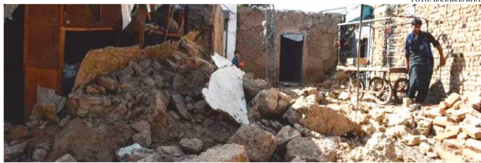
MUITAS VÍTIMAS FALECERAM NO DESABAMENTO DE TELHADOS E MUROS.
