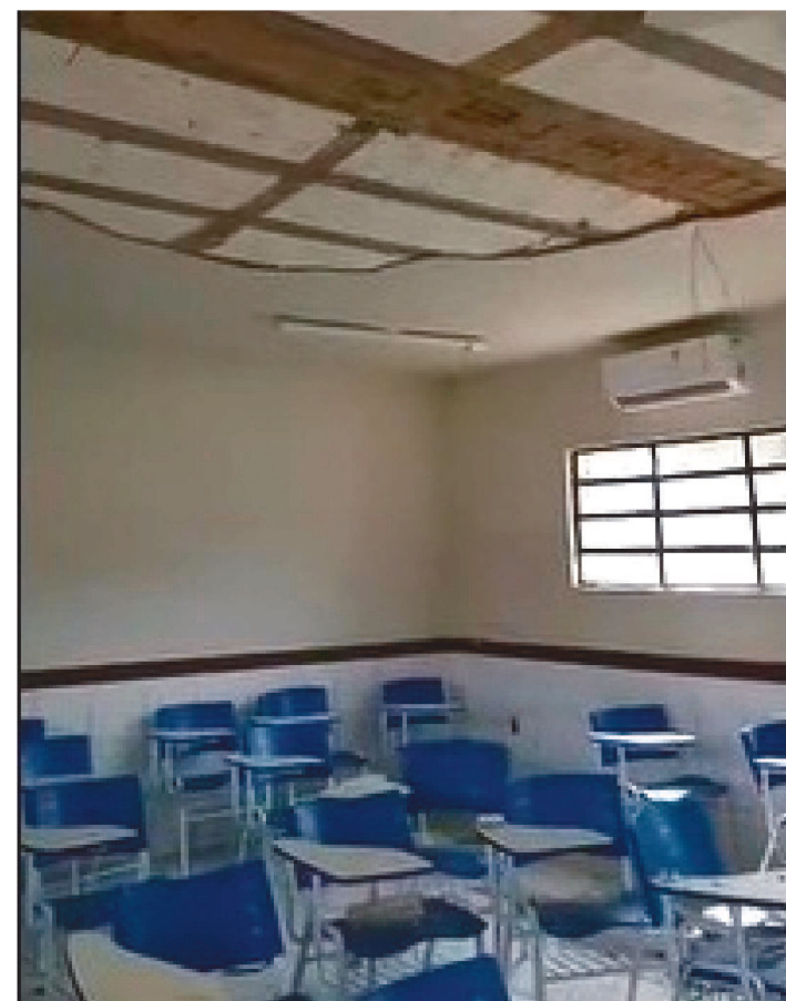
O REBOCO DO TETO DA SALA CAIU SOBRE ALGUNS ALUNOS
