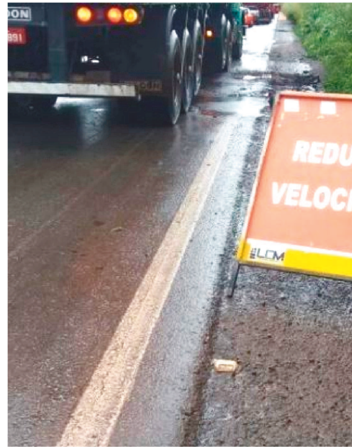
A INTERDIÇÃO PARA OBRAS ACONTECERÁ NO KM 16 DA BR-135
