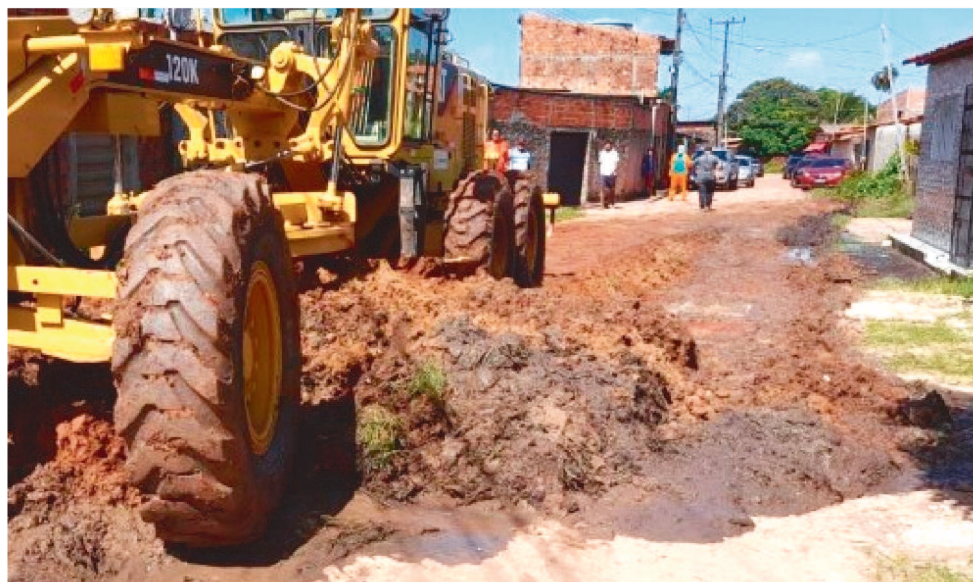
DRENAGEM ESTÁ SENDO FEITA PARA DAR FIM AOS PROBLEMAS DA LAMA E ESGOTO
