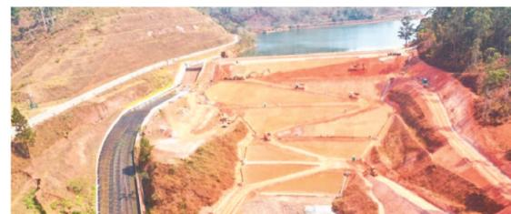
A estrutura tem a função de conter sedimentos e armazenar água, foi construída pelo método a jusante e contém cerca de 14 milhões de m³ de sedimentos e água.
