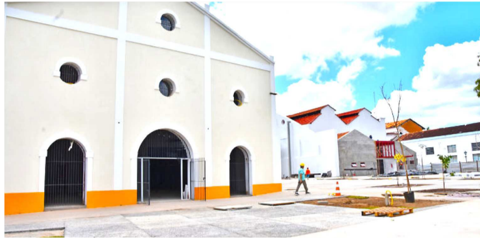
OBRAS COMPLEXO TRAPICHEA RECEBEU INVESTIMENTO DE MAIS DE R$ 60 MILHÕES
