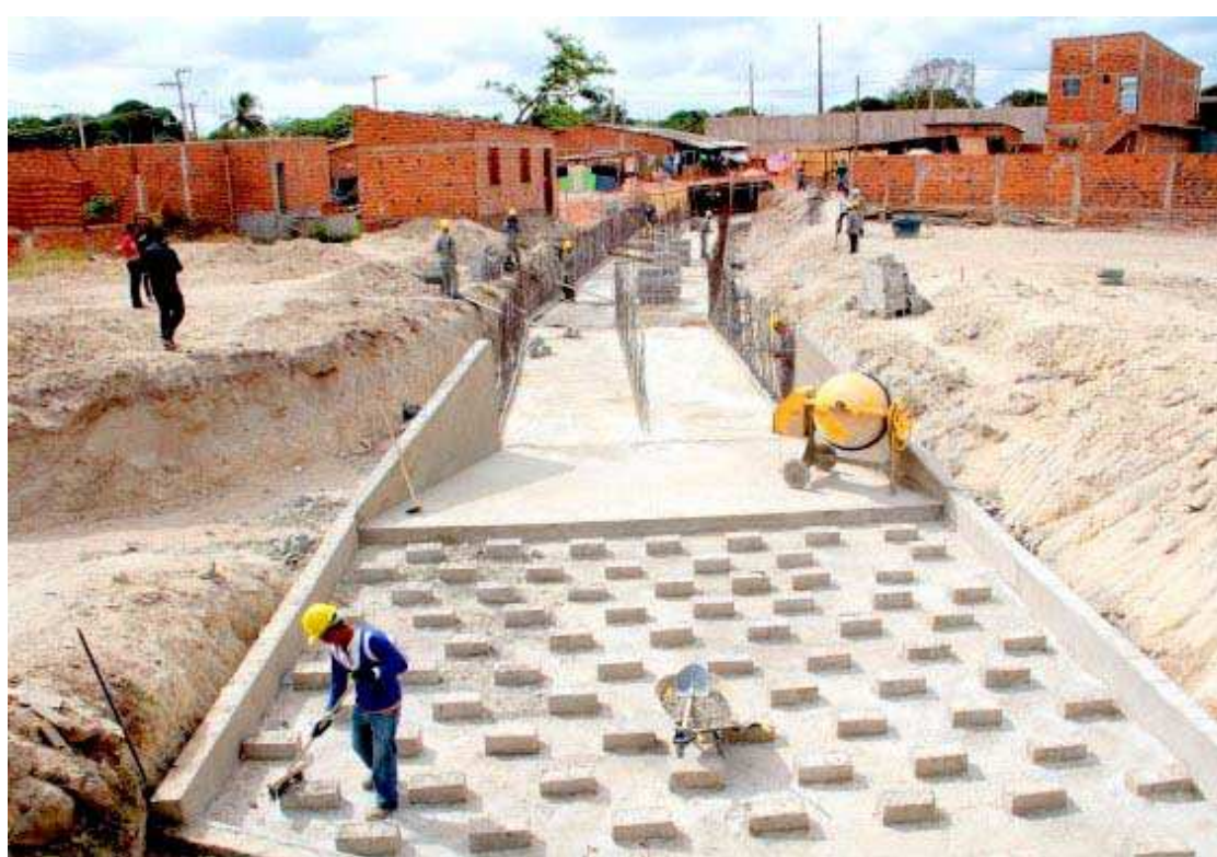
Obras de requalificação asfáltica executadas na Vila Fialho e Jardim Eldorado estão em fase de conclusão
