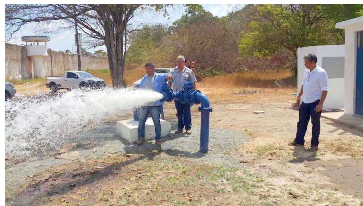
Novos poços beneficiarão cerca de 30 mil pessoas atendidas pelo sistema
