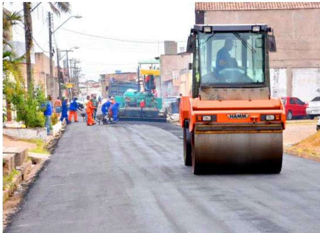
Máquinas pavimentaram as ruas 32, 33, 42 e 44 do bairro da Areinha por meio do projeto de urbanização
