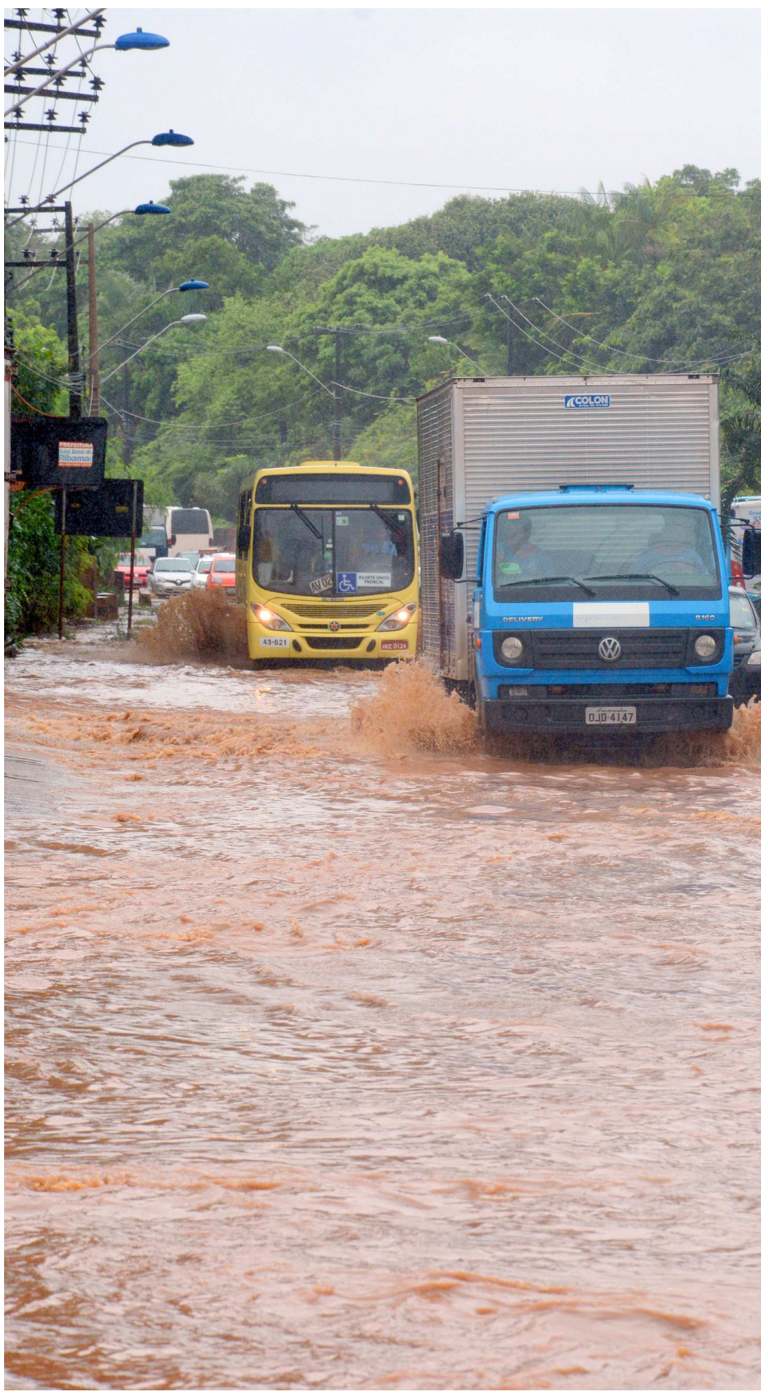
Estrada de São José de Ribamar ficou completamente alagada pela falta de escoamento da água da chuva
