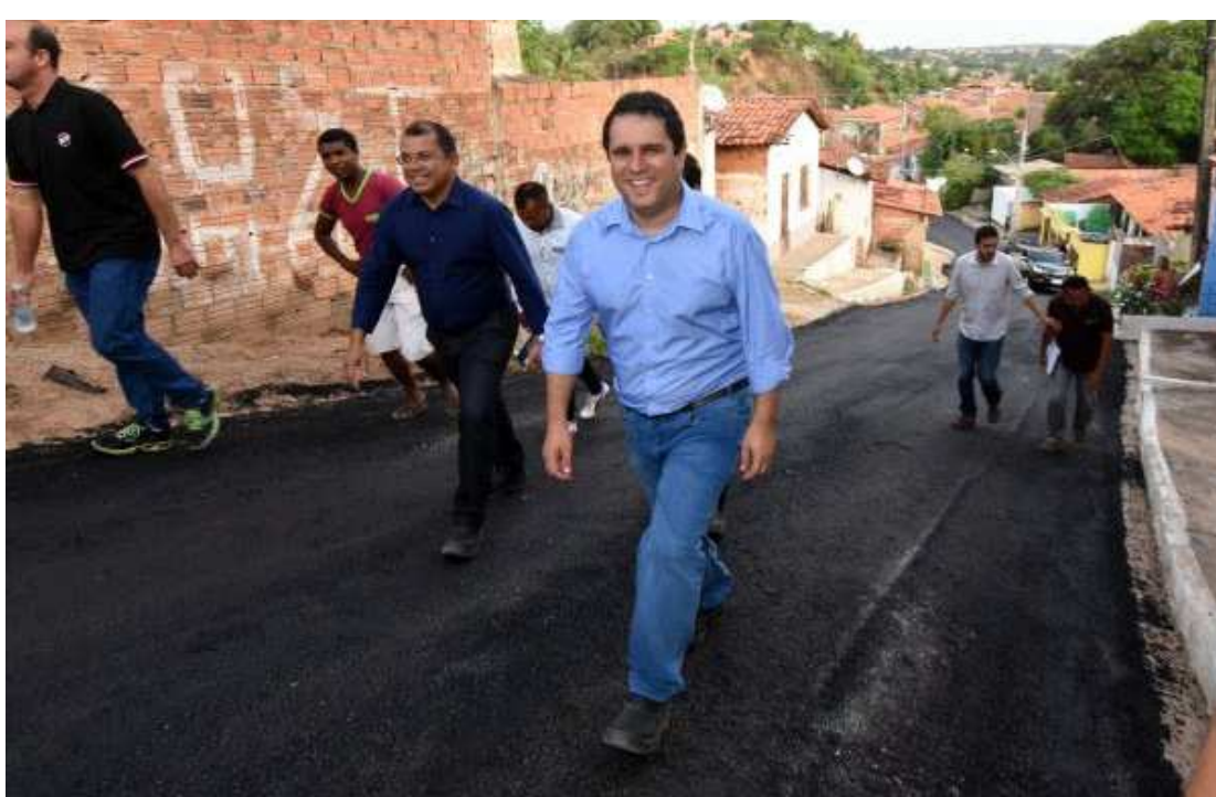
Prefeito Edivaldo Holanda Júnior esteve no Polo Coroadinho acompanhando as obras de urbanização
