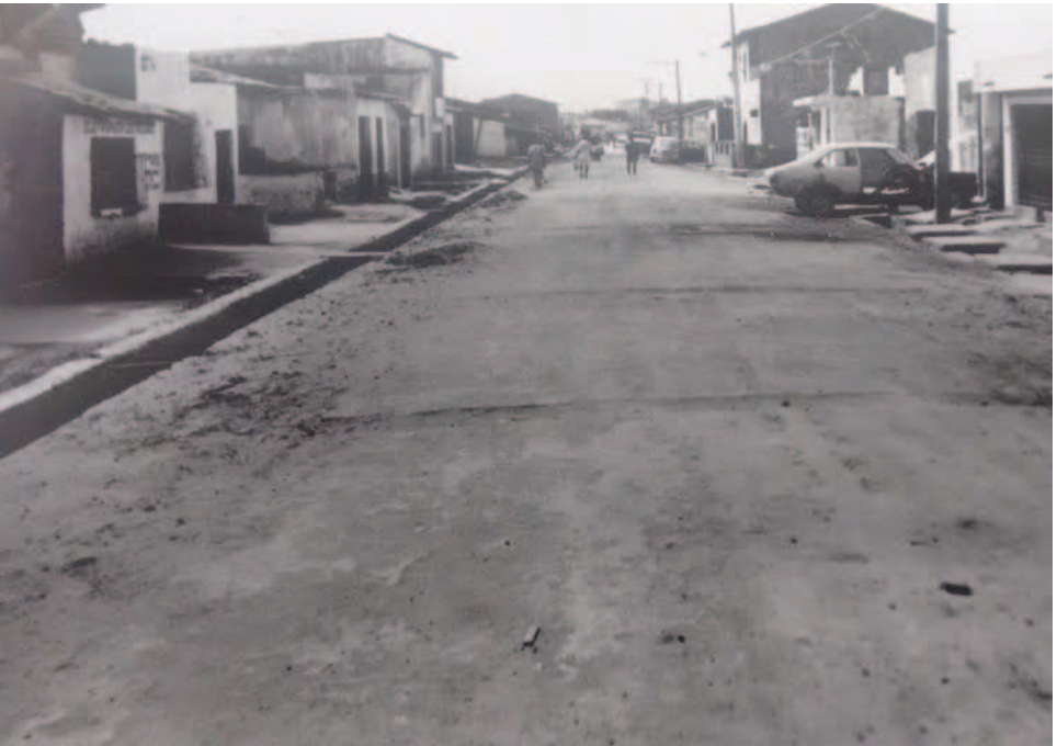
Rua Paulo Frontin, no bairro Monte Castelo, em São Luís. O registro foi feito no dia 1º de março de 1991, quando a via estava sendo preparada pela prefeitura para receber camada asfáltica. Nos últimos anos, a rua se tornou um ponto importante de comércio, por ficar próximo ao Centro da cidade.
