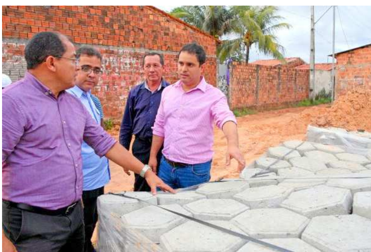
Edivaldo percorreu o bairro, completamente transformado após obras
