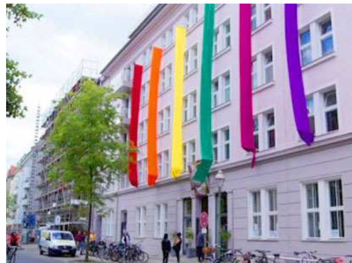
O acolhimento será em um edifício de quatro andares na capital alemã
