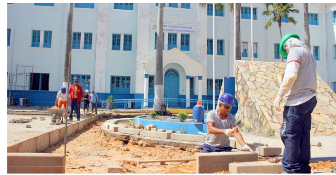
A reforma está prevista para ser concluída em março deste ano
