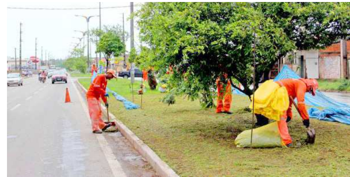
Prefeitura realiza limpeza para escoamento da água em galerias
