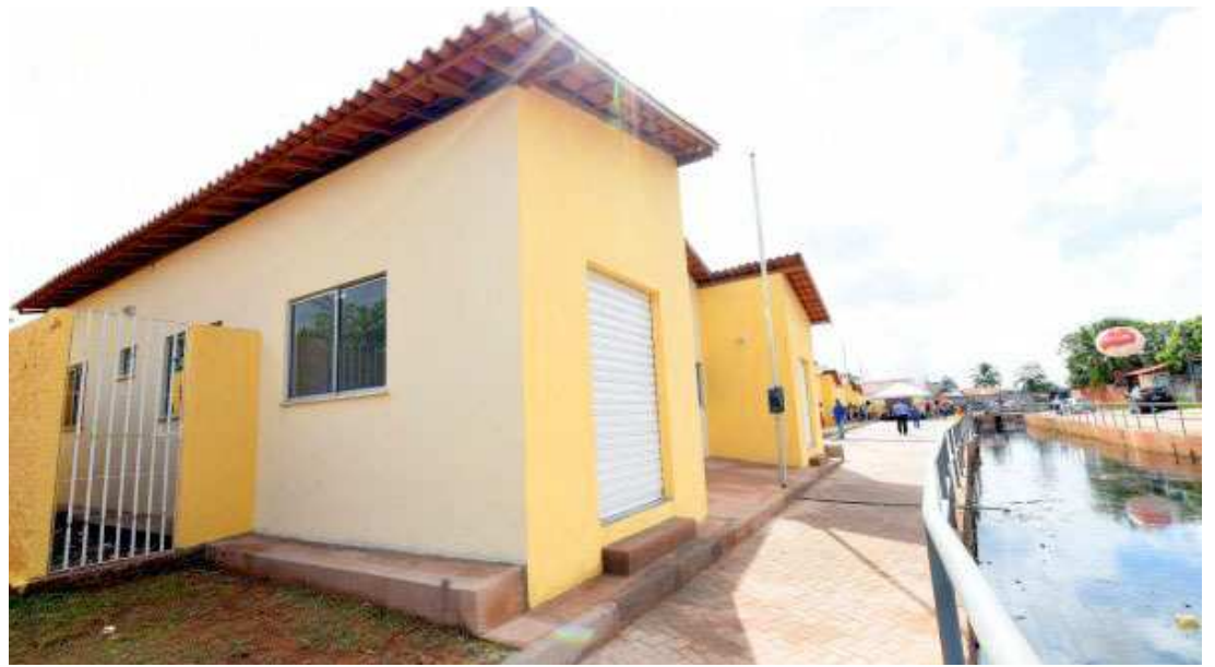
Rio das Bicas I conhece as novas instalações da região, que deve contar com 35 casas e mais urbanização
