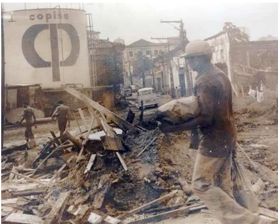
Registro da obra de urbanização na região do Anel Viário, final da Rua Afonso Pena, em 29 de maio de 1978
