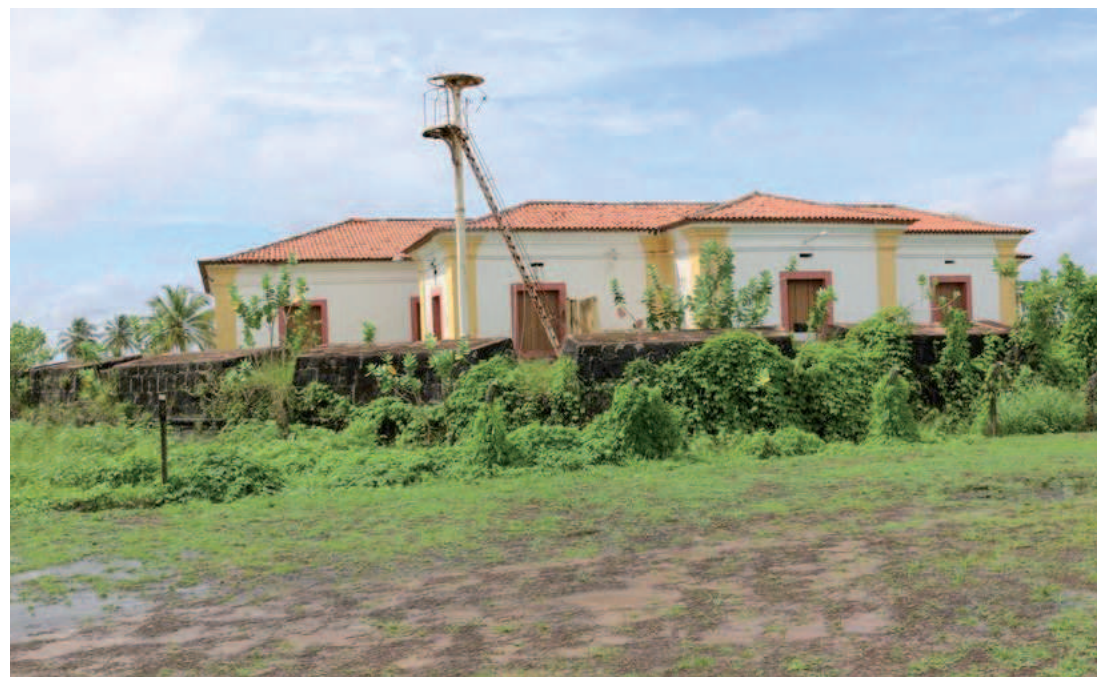
Projeto de recuperação do imóvel secular está orçado em R$ 2,7 milhões e será realizado dentro de oito meses
