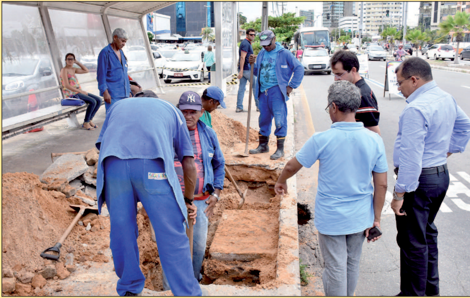
O serviço de drenagem nos bairros de São Luís foi iniciado na Avenida Colares Moreira, no Renascença
