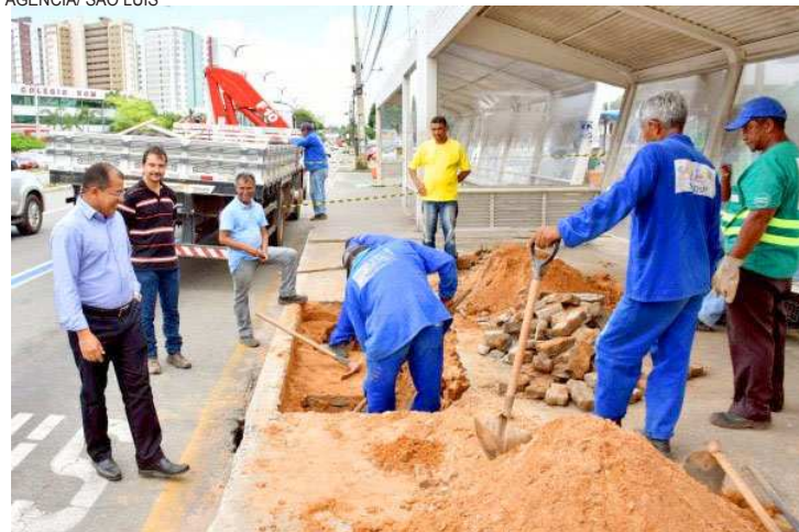
Operários trabalharam na desobstrução de galerias, próximo a paradas
