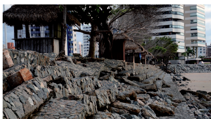
Pedras de paralelepípedo foram colocadas para conter a força da maré
