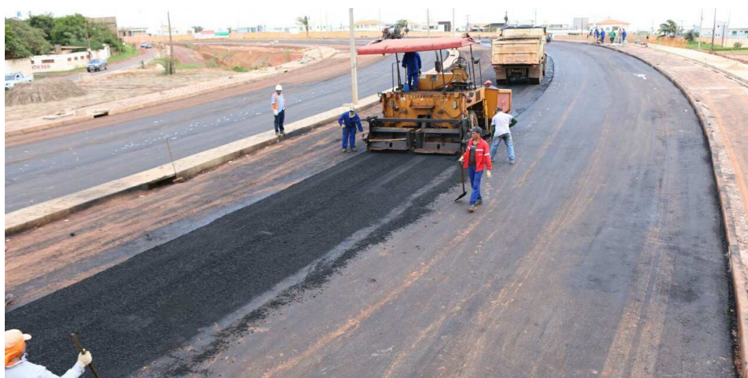
Importante via de ligação entre os municípios da região metropolitana, a rodovia está sendo duplicada
