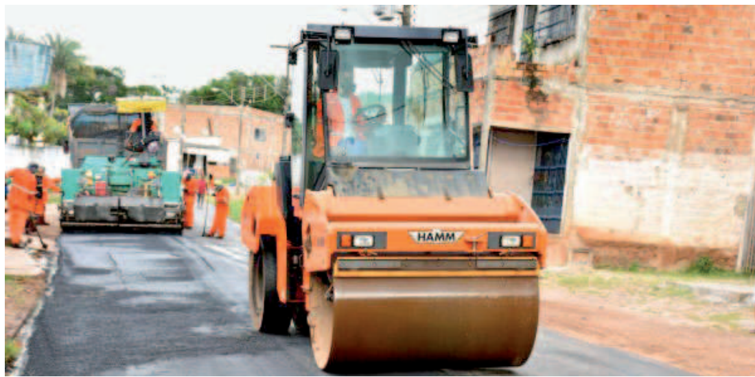
Obras no Residencial Paraíso devem melhorar a urbanização da área, além da drenagem das ruas do bairro
