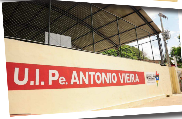
Fachada da escola Padre Antônio Vieira, que foi totalmente reconstruída
