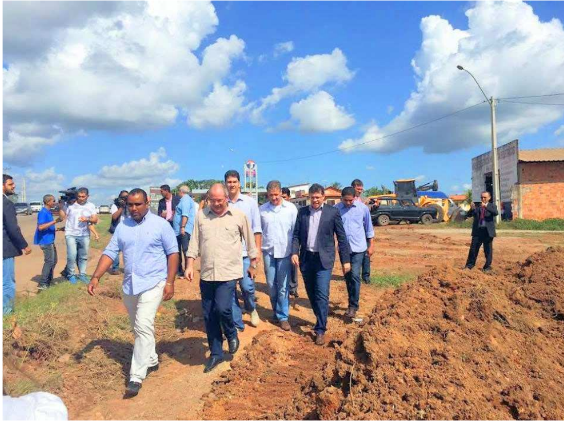
Comitiva de deputados percorre os canteiros de obras da duplicação da Br-135 para analisar andamento
