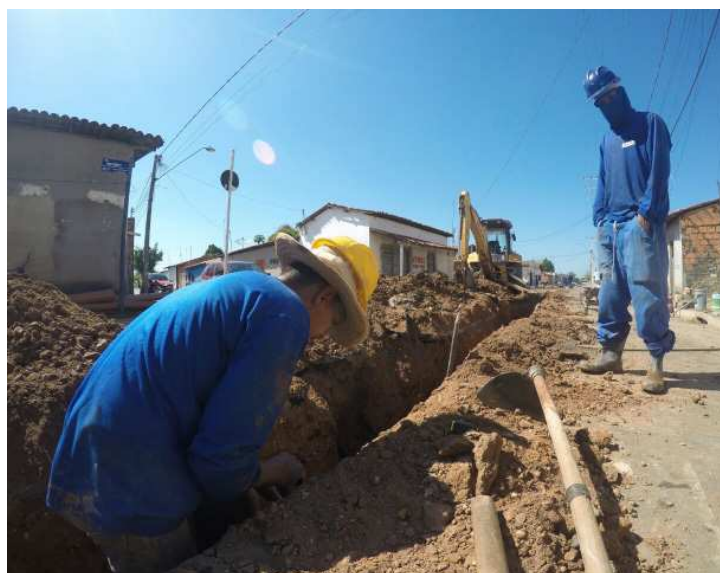
Obras de infraestrutura estão sendo realizadas em Imperatriz
