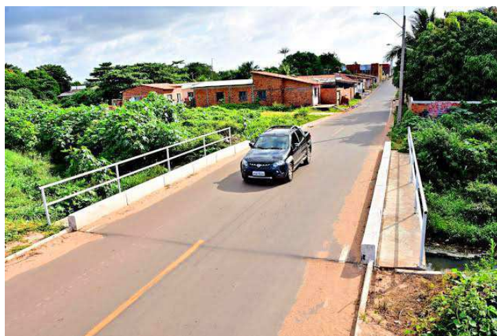
Outra obra que dará mobilidade é a ponte no bairro do S. Cristóvão
