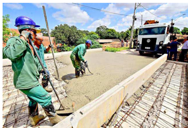
Operários estão realizando concretagem na Cidade Operária
