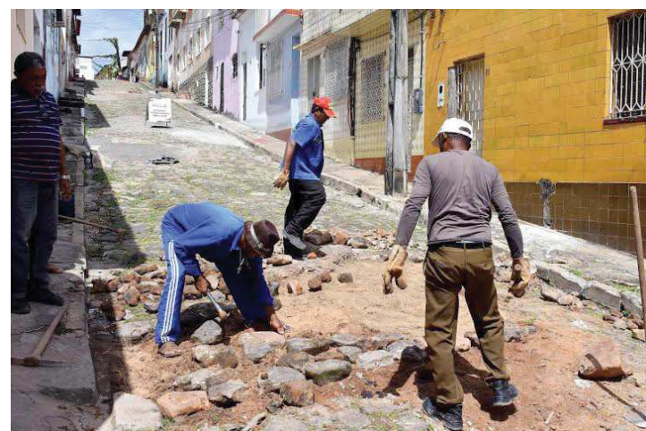
Operários estão trabalhando na limpeza e recuperação do calçamento
