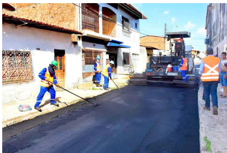
Operários trabalham na recuperação asfáltica das ruas da Alemanha
