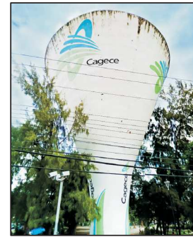
Caixa-d'água da Praça da Imprensa, em Fortaleza
