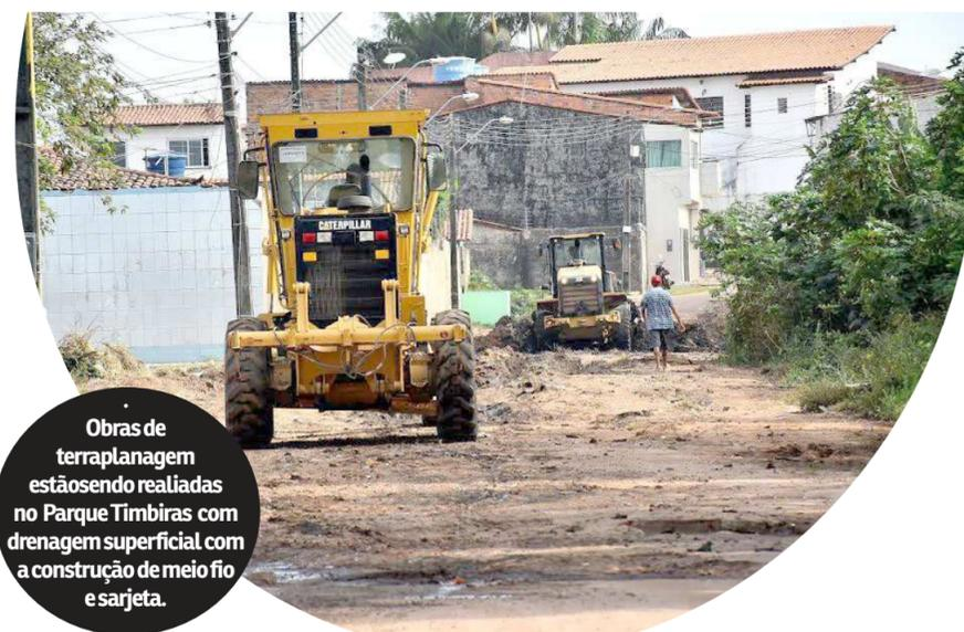
Obras de terraplanagem estão sendo realizadas no Parque Timbiras com drenagem superficial com a construção de meio fio e sarjeta.
