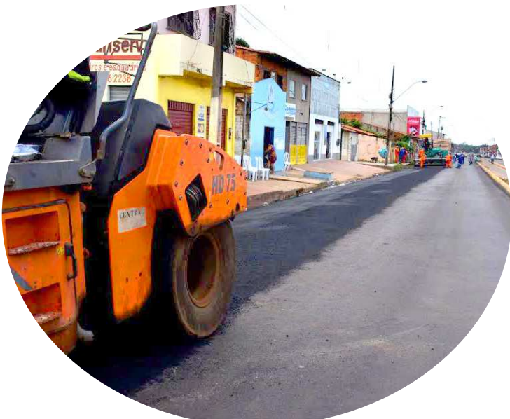
Obras de pavimentação estão sendo realizadas na Avenida Tibiri
