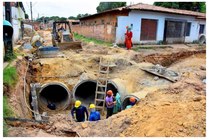
Bairro recebeu a implantação de tubulações de manilhas de concreto
