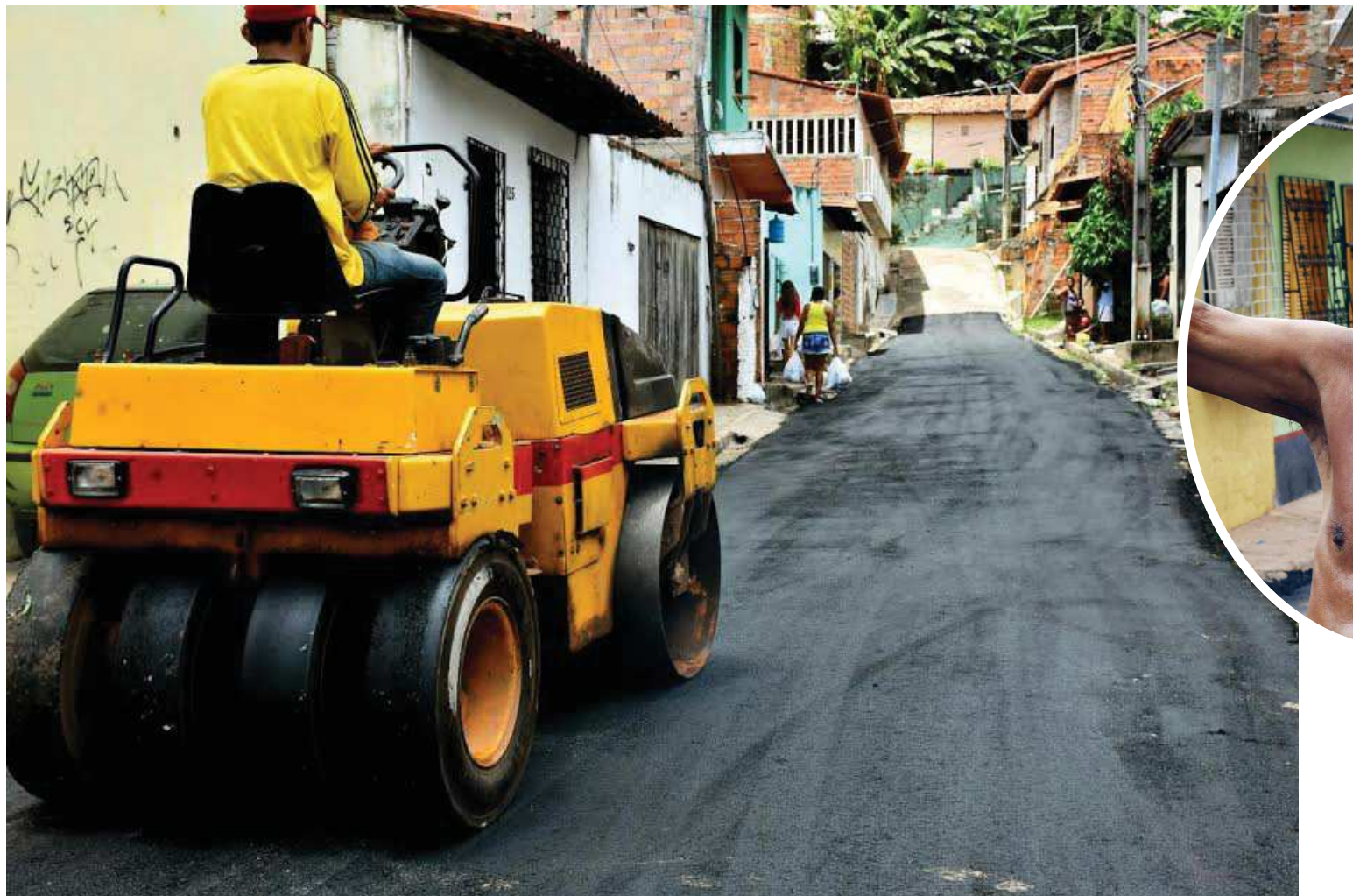
Máquinas realizaram asfaltamento da Estrada da Vitória, entre a Avenida João Pessoa e Avenida dos Franceses, que tem cerca de 1,5 quilômetro
